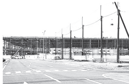
三菱重工小牧北工場の新築工事の様子
