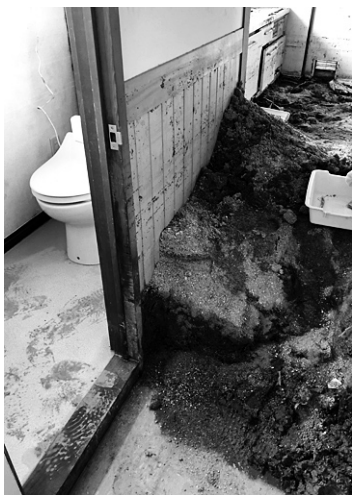
ほとんどの住宅で家の中に大量の土砂が流れ込んだ
